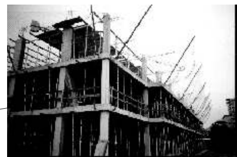
Fig.6 Anclaje abatible para pescante de red
